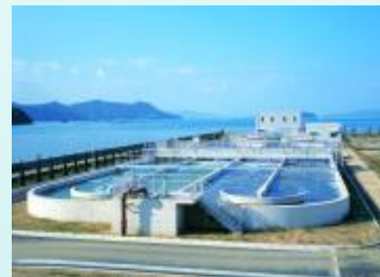
工場排水処理場
